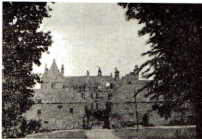
Chateau Sotteville, Sotteville France
